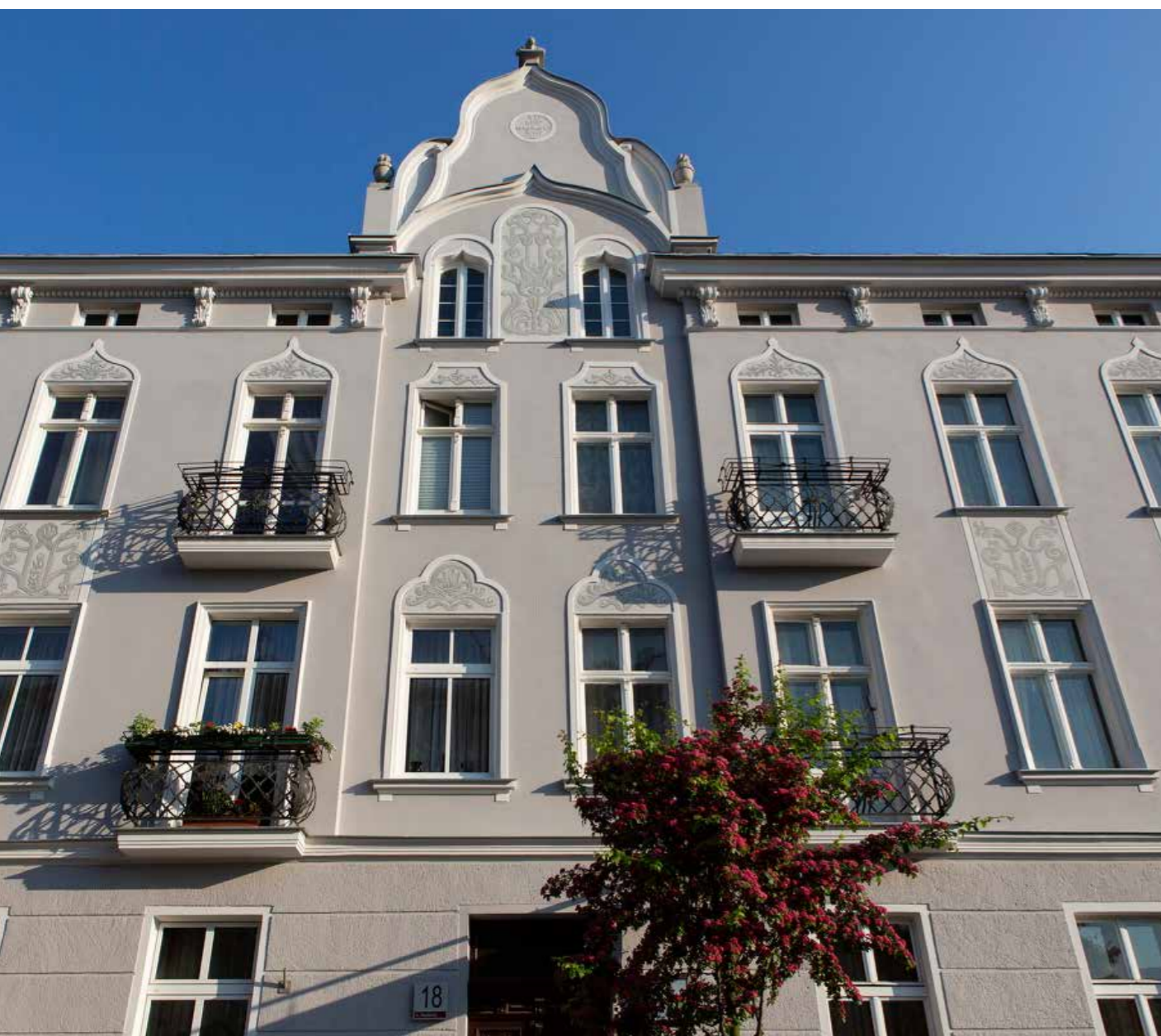
Odnowiona elewacja kamienicy przy ul. Wajdeloty 18, nagrodzona w 2017 r. w miejskim konkursie na najładniejszą elewację. Fot. Jerzy Pinkas (gdansk.pl)
