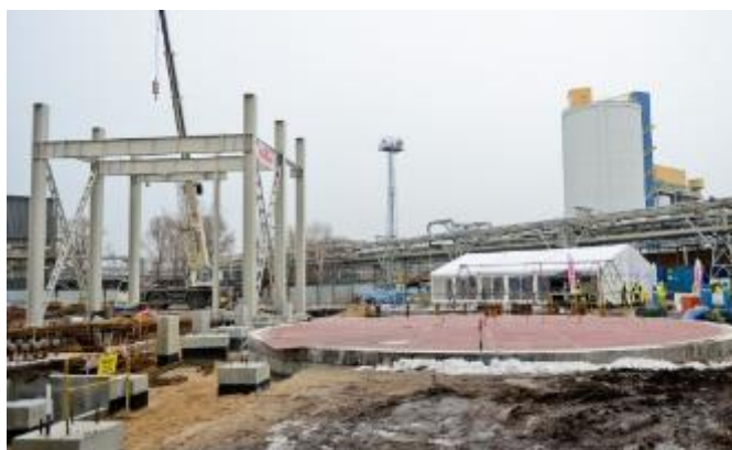
Rys. 43. Budowa instalacji mokrego odsiarczania spalin w Elektrociepłowni Gdańskiej 74
