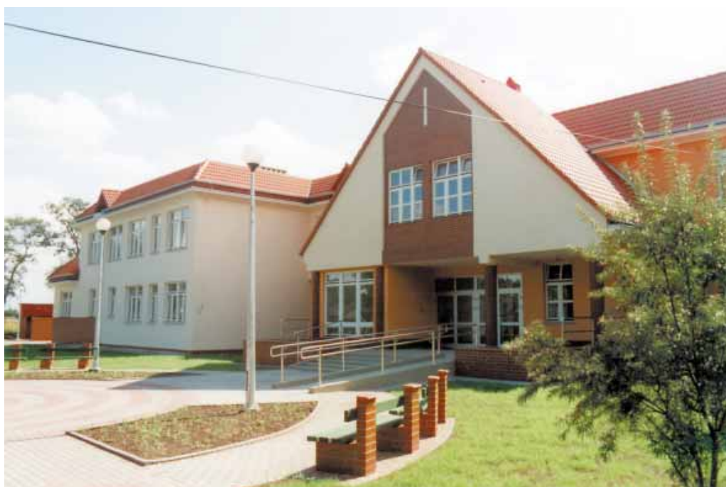
Nowa, dobudowana ostatnio, część szkoły w Świbnie
